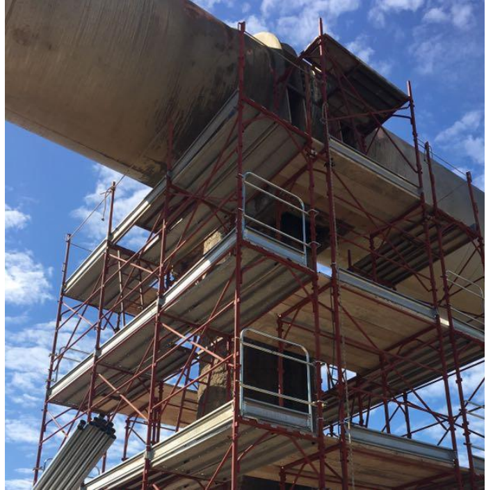
Foto 3 - Verifica giunto di dilatazione
