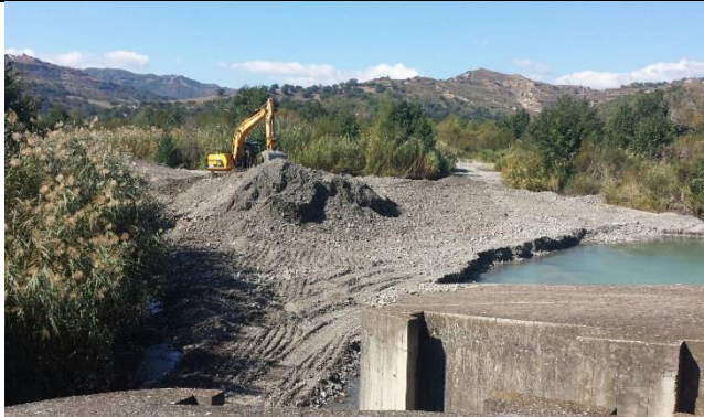
Foto 5 - Scavo per riprofilatura dell'alveo a monte della traversa
