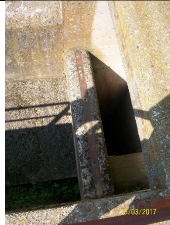
Foto 4 - Soglia sfiorante e partenza canale di derivazione
