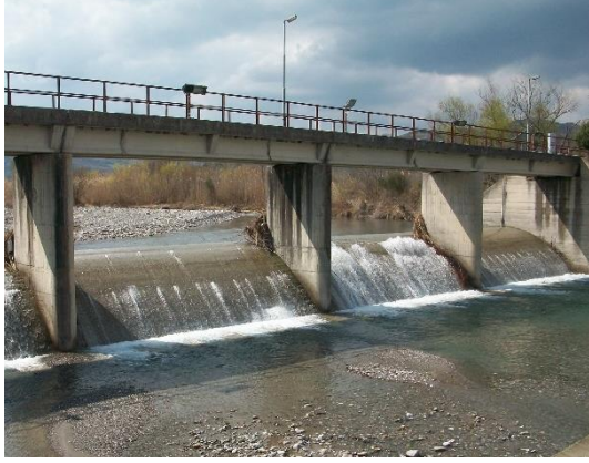
Foto 1 - Soglia sfiorante sx e passerella di servizio
