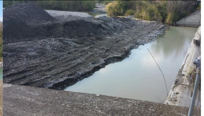
Foto 6 - Riprofilatura dell'alveo a monte della traversa
